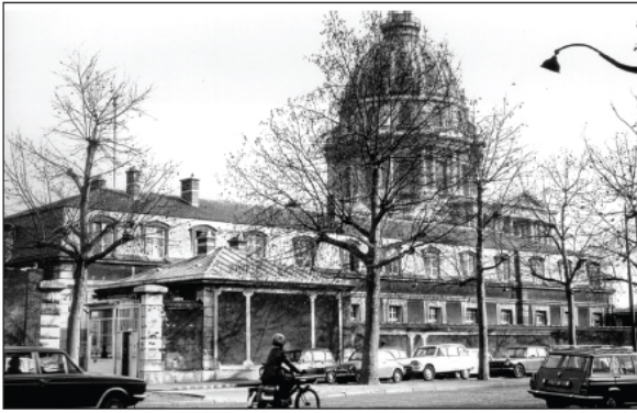
2 bis, avenue de Tourville, siège du 2 e bureau
