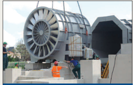
Construction d'une soufflerie à l'INSAE-SUPAERO
